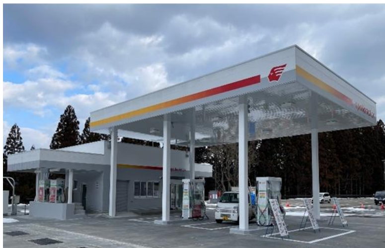
▲令和6年3月に新設された三島町サービスステーション
