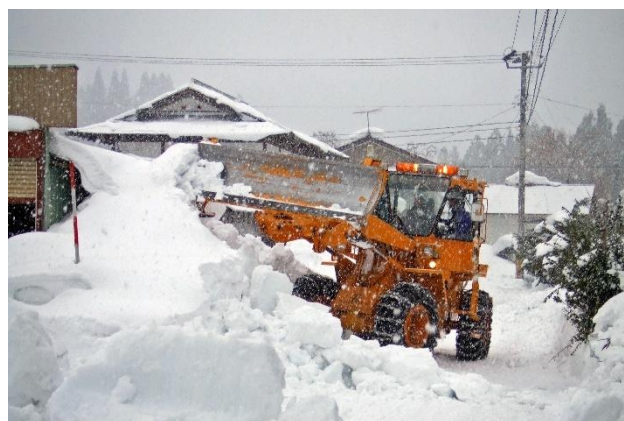
▲冬期除雪作業
