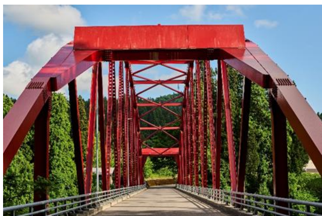
▲道路施設（三島大橋）
