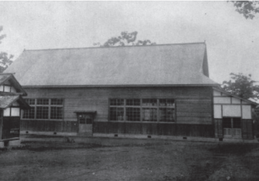
▲無料診療所が設置された宮下国民学校講堂の外観
