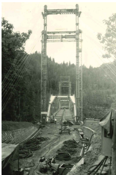
建設中の三島大橋・昭和 50 年
