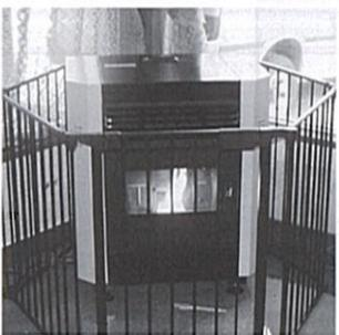
←樹木を粒状に加工した「木質ペレット」を燃焼させるペレットストーブは、木質バイオマスを活用した代表例である。写真は、ふるさと荘に設置されているペレットストーブ。
