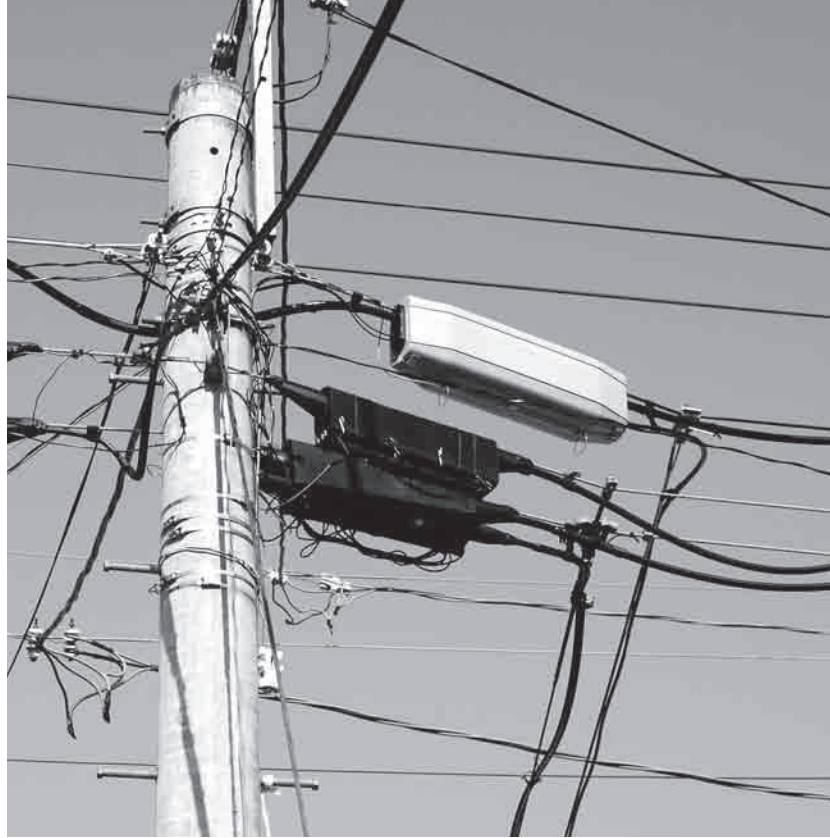
電柱を渡って総延長 38.9km の光ファイバーケーブルが敷設された。白い箱から伸びているのが町の光ファイバーケーブル。黒い箱から伸びているのは NTT の電話線
