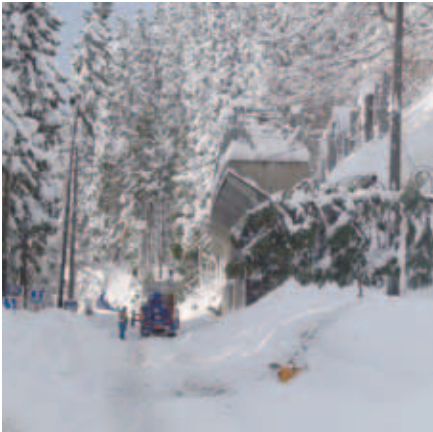
▲電気復旧作業中の様子（高清水地区）
