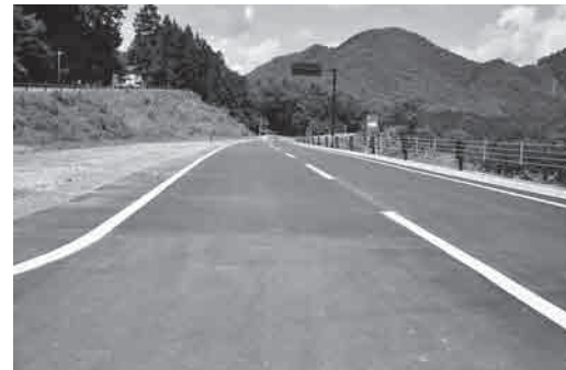
8月29日に開通した国道400号線
