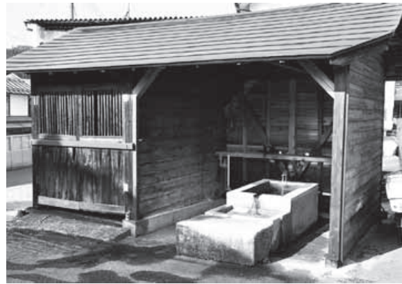
整備を完了した荒屋敷地区の水場
