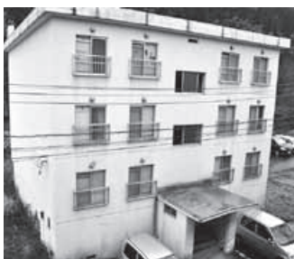
(上) 町営住宅の中で最も新しい宮下居平住宅。木造建築の特徴を生かして建てられ、世帯用2戸、単身者用4戸がある
