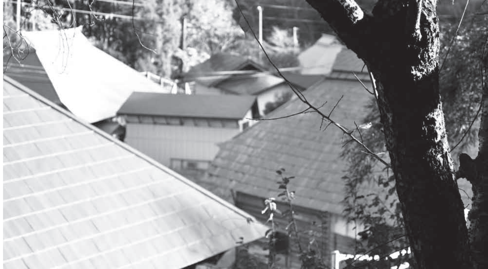
町内の各地区では、空き家の放置による集落の荒廃が心配されている
