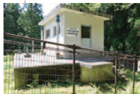
滝谷配水池 容量 82m 3 【給水地域】 滝谷地区
