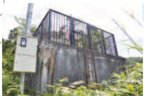
間方配水池 容量 36m 3 【給水地域】 間方地区
