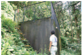
滝原配水池 容量 30m 3 【給水地域】 滝原地区
