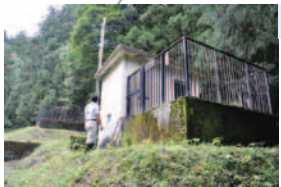
早戸居平配水池 容量 32m 3 【給水地域】 早戸地区
