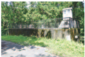
宮下配水池 容量 233m 3 【給水地域】 宮下・荒屋敷・高清水地区
