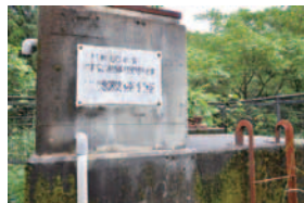
小山配水池 容量 4.5m 3 【給水地域】 小山地区
