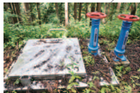
大登配水池 容量 60m 3 【給水地域】 大登・川井地区
