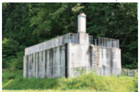
大谷配水池 容量 254m 3 【給水地域】 大谷・桑原・中平・宮下・荒屋敷地区
