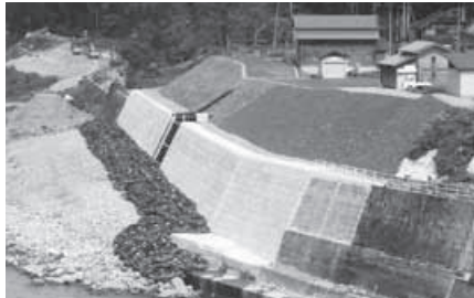
金山町上田の護岸復旧状況
