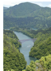
只見川第一鉄橋
