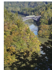
只見川第一鉄橋
