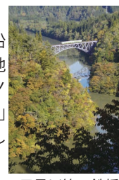
只見川第一鉄橋
