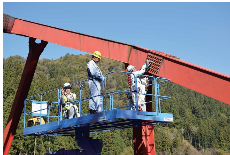
ボルト交換作業の様子
