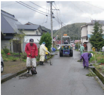
▲側溝清掃作業の様子（松原）
