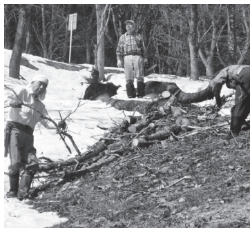
▲残雪の中での整備作業の様子(西方)
