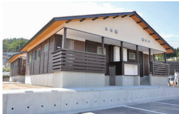
今年度完成した「上ノ原住宅 5 号棟」
