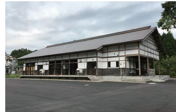
完成した「工人の館」
