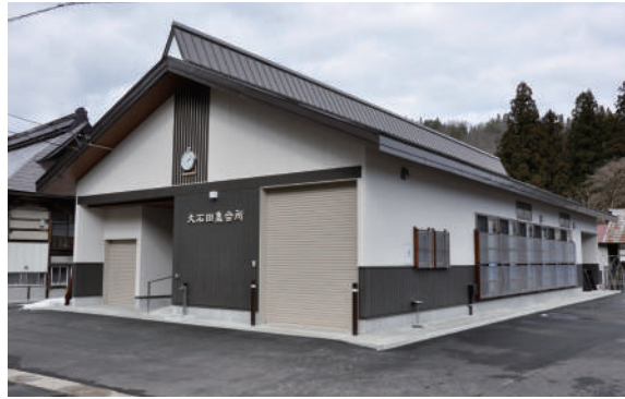
完成した大石田集会所
