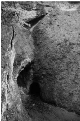
岩盤を掘り抜いた水路
