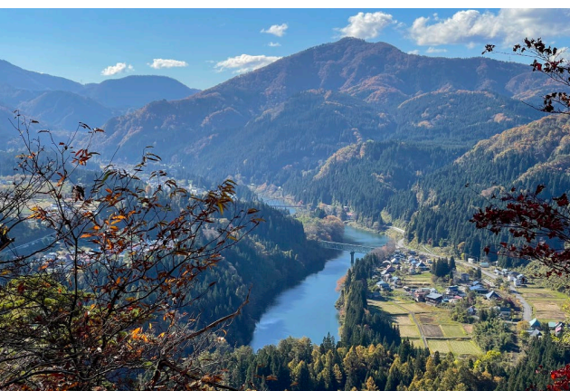
▲ 只見川に架かる第二只見川橋梁
