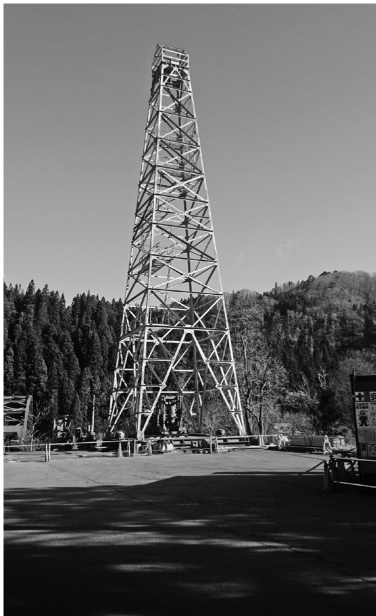
教育宿舍前の温泉掘削現場
