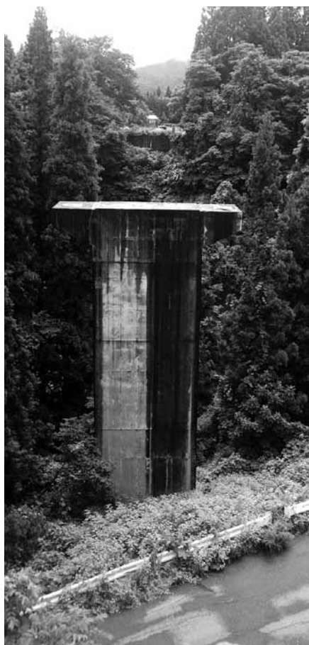
工事再開が望まれる国道400号橋脚
