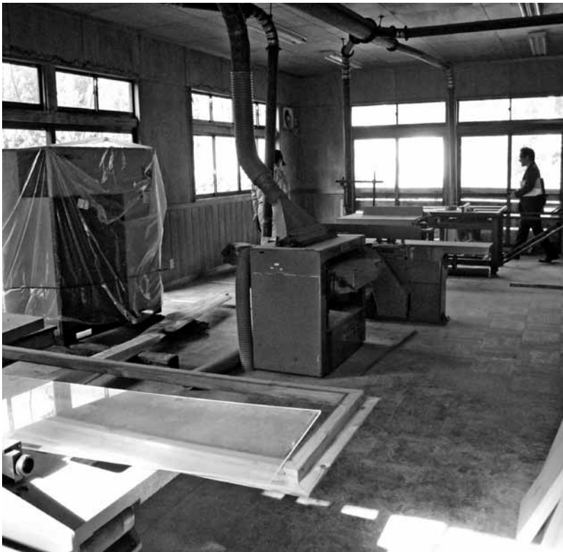
使用されていない「工人の館」の木工加工場
