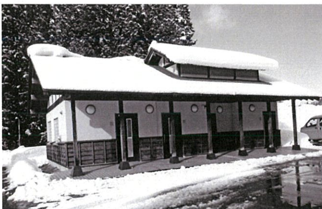
尾瀬街道みしま宿の屋外トイレ
