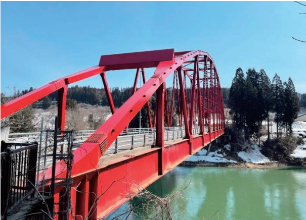
▲ 道路施設（三島大橋）
