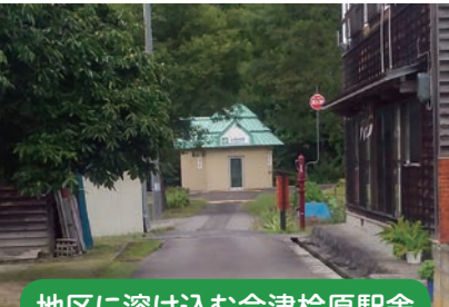
地区に溶け込む会津松原駅舎
