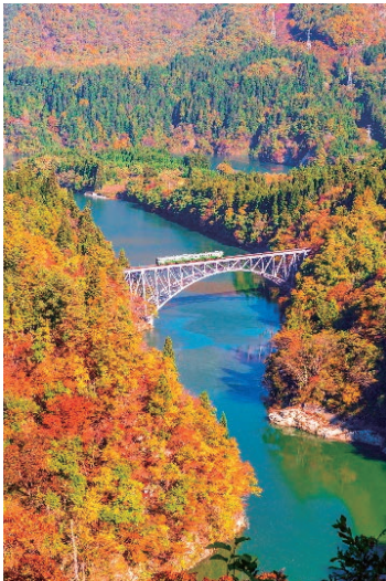
〔第一只見川橋梁〕
